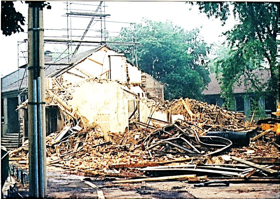
(aus der Sammlung Krein) 1983 – Abriss der „neuen“ Volksschule (erbaut 1914)
