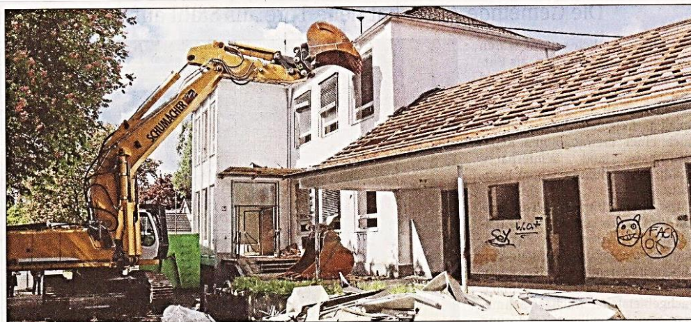
Der Bagger beißt zu: Gestern hat der Abriss der Alten Schule in Volmershoven begonnen.
