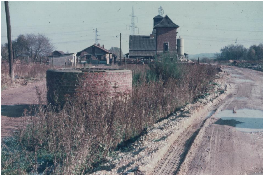
(aus der Sammlung Heinrich Lenz) Schachtanlage Didier-Werke – Grube Eiche nahe der Schmalen Allee
