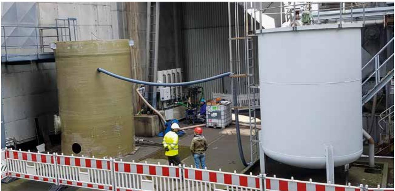
Abb. 2: Versuchsanlage (Wäscher, Strahlpumpe, Vorlagebehälter und Dortmund-Brunnen) am Kraftwerk Wilhelmshaven
