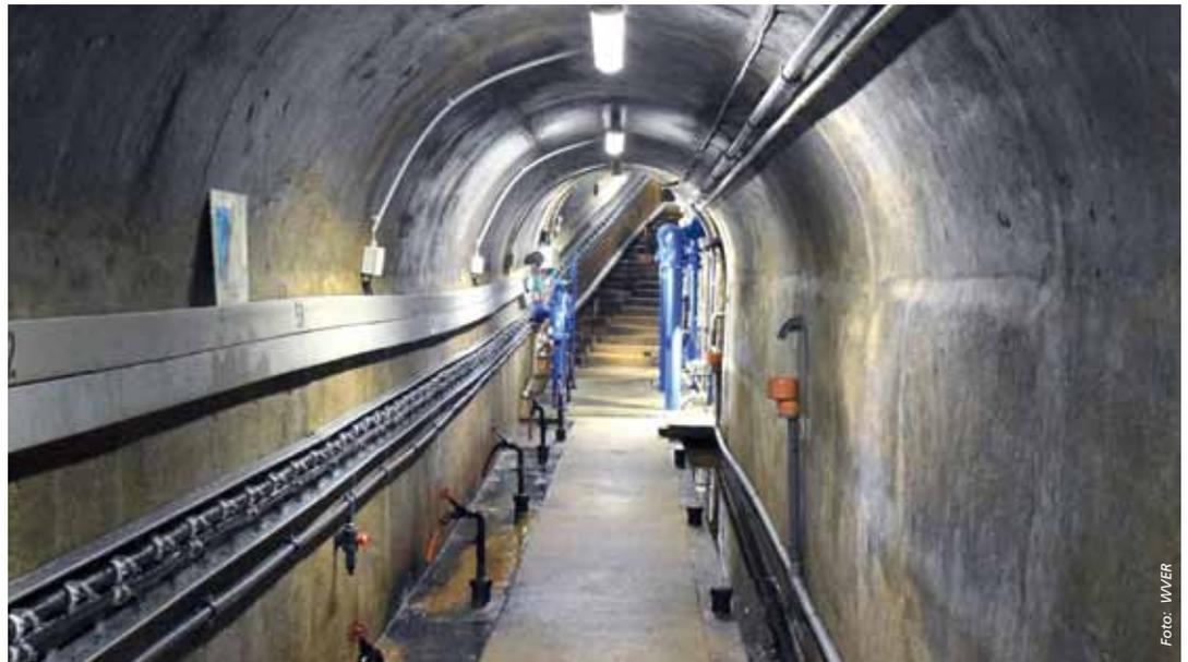
*Blick in den Kontrollgang mit den blauen Sickerwasserdrainage-Pumpen an der tiefsten Stelle. Hier fällt immer etwas Sickerwasser an, das kontinuierlich gemessen und nach außen abgepumpt wird. Sollte es einen verstärkten Anfall von Sickerwasser geben, weiß man, dass irgendwo im Untergrund etwas nicht stimmt und kann eingreifen. Viele weitere technische Details erfahren Sie bei den Führungen durch die Staumauer am 22. September.*
