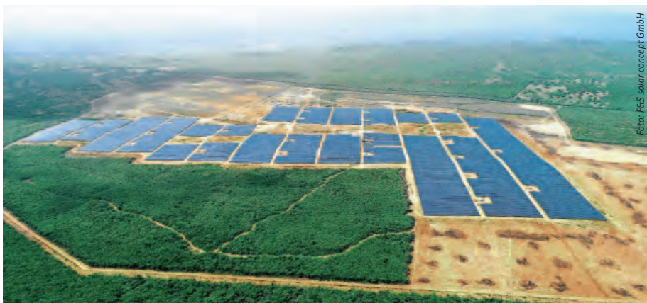
|| 215.000 Module auf einem 280 Fußballfelder großen Areal: „F&S“ aus Euskirchen hat in der Dominikanischen Republik das größte Solarkraftwerk der Karibik fertiggestellt.
