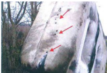
Der illegal entsorgte Öltank. Im Bild markiert sind die Bohrlöcher aus denen das Altöl austrat.
