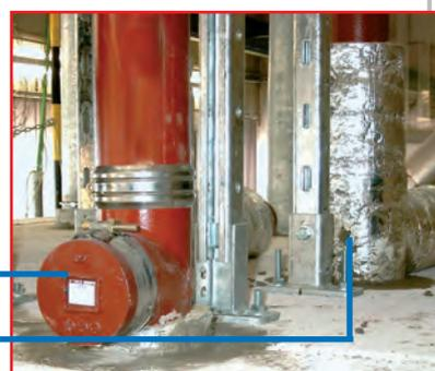
**Dämmung nach ABP P-3725/4130-MPA BS der Firma Rockwool**
