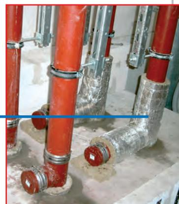
In den Deckenbereichen wurden die beiden gusseisernen Fallrohre mit R90-geprüften Brandschutzlösungen der Fa. Rockwool versehen.
