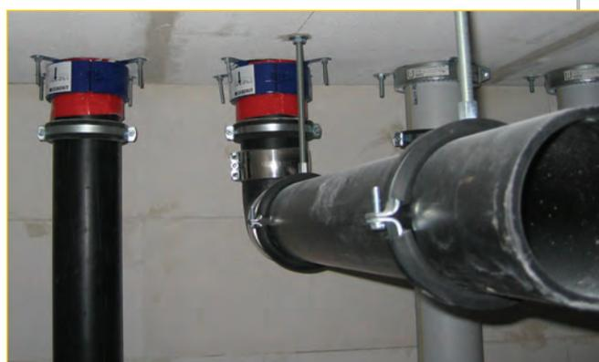
Die R90-geprüften Brandschutzmanschetten für Kunststoff-Abflussrohre ver-
