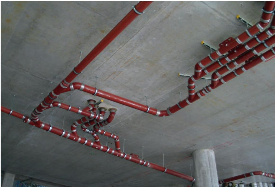
Foto: Nichtbrennbares gusseisernes Abflussrohrsystem PAM-GLOBAL® S (Firma SAINT-GOBAIN HES)
