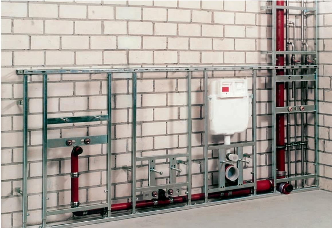
Bild 2: Komplett Abwasserinstallation aus gusseisernen Abflussrohren (SAINT-GOBAIN HES)
