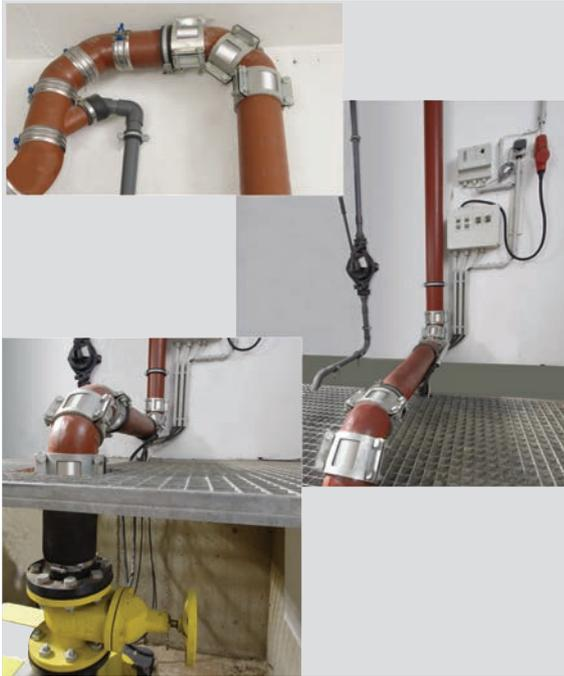
Fotos: Ausführungsbeispiele von Druckleitungen aus gusseisernen Abflussrohren
