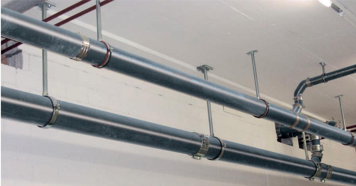
Foto: Nichtbrennbares gusseisernes Abflussrohrsystem mit Sonderbeschichtung Typ MLK-protec (Firma Düker)
