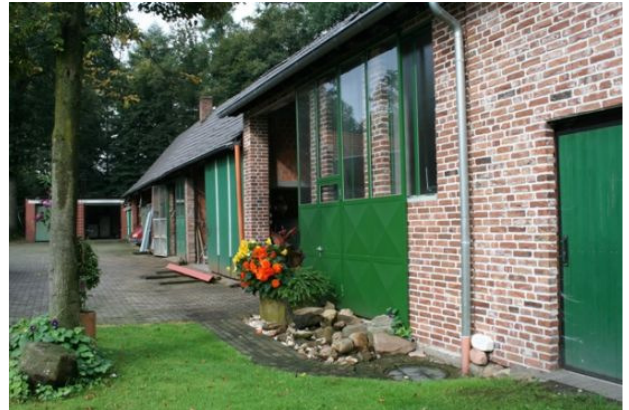
In Raesfeld ist in der ehemaligen Maschinenhalle eine Werkstatt für Metallbau und eine Bauschlosserei untergebracht.
