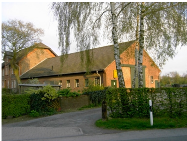
Im ehemaligen Kuhstall entstand ein Heizungs- und Sanitärbetrieb in Rees.
