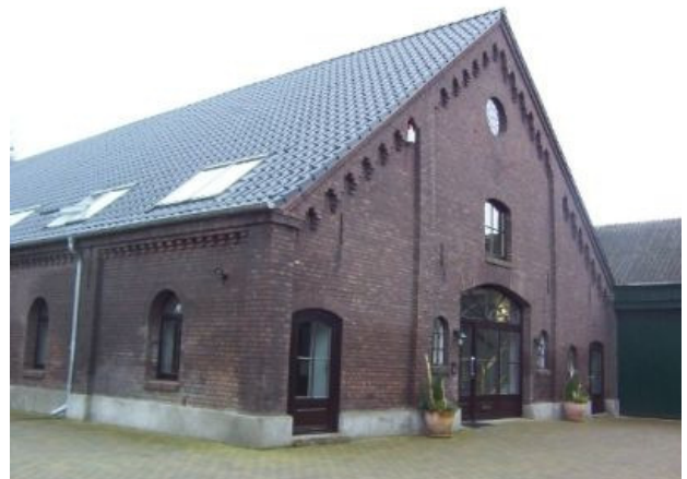
In Emmerich wurde in einer Scheune ein Steuerberatungsbüro errichtet.
