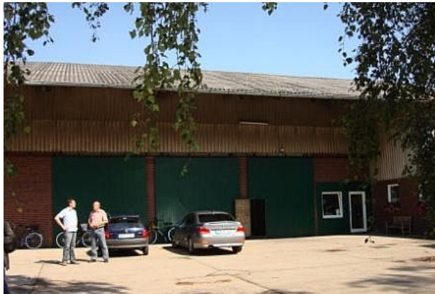
In Südlohn wurde eine Maschinenhalle zu einem Verpackungsservice mit Büro umgewandelt.
