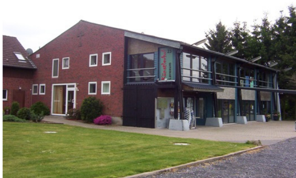
In der Scheune und in den Stallungen finden sich jetzt Wohnungen und Ateliers.
