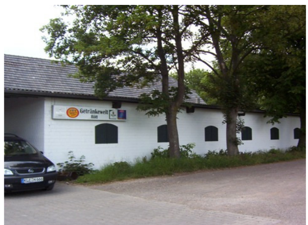
In Rheurdt wurde der Bullenstall zu einem Getränkemarkt umgenutzt.
