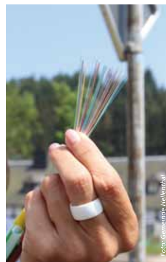
Die bunten Glasfaserkabel sorgen für schnellen Internetanschluss im Gemeindegebiet.
