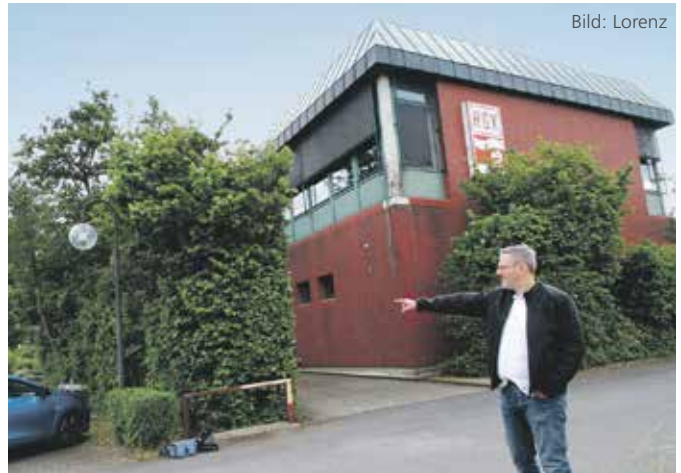
Günther Wischum zeigt, in welchem Bereich das Gebäude erweitert werden soll.
