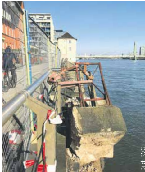
Anliegende Schiffe hatten Festmachvorrichtungen aus der Kaimauer gerissen.
