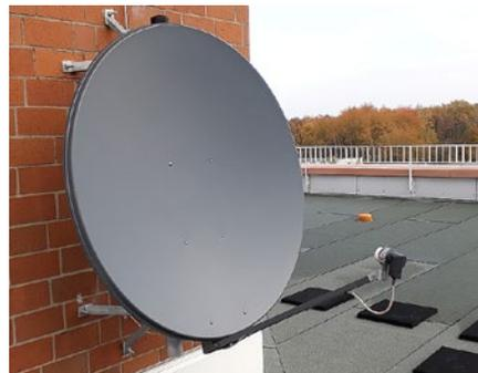
Empfangsantenne für Satellitenrohdaten auf dem Dach des Bildungszentrums des DWD in Langen (© P. Schmitt)
