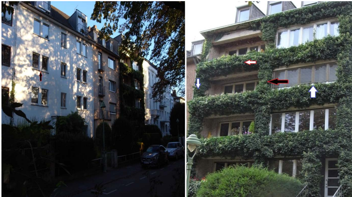
Abb. 1: Die für die Untersuchung herangezogenen Fassaden an der Poppelsdorfer Allee in Bonn. Linkes Bild: Kontrollfassade links im Vordergrund; Efeu-bewachsene Fassade im mittleren Bereich der rechten Bildhälfte. Rechtes Bild: Das Gebäude mit dem ca. 30 Jahre alten Efeubewuchs. Die Pfeile indizieren die Anbringungsstellen der i-buttons (siehe Text). Aufnahmen: Edelmann
