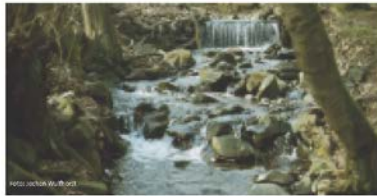
Absturz vor der Umgestaltung. Foto am 15. März 1999
