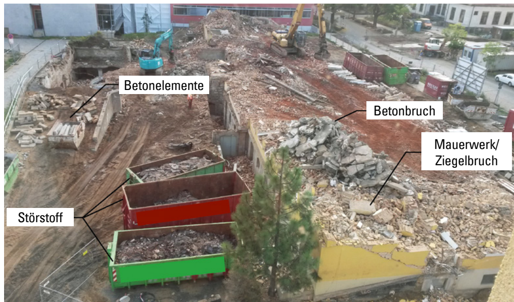
Abbildung 98: Abbruchbaustelle mit vorsortiertem Bauschutt
