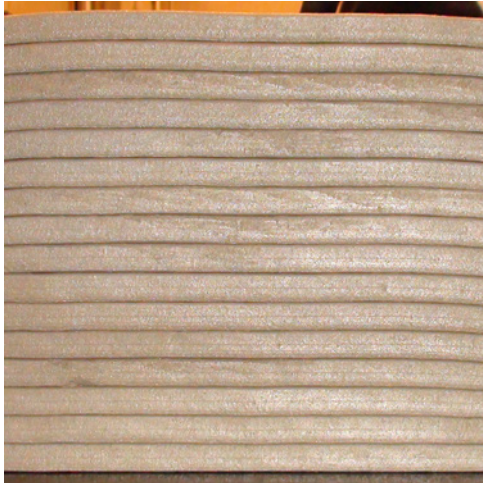
Abbildung 92: Ausschnitt einer gedruckten Beton-Wand (oben)
