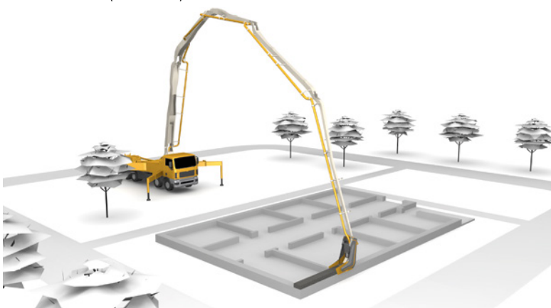
Abbildung 90: Beton-3-D-Druck direkt auf der Baustelle (Animation)
