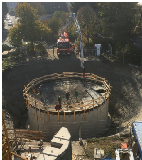
Abbildung 41: Der Eisspeicher des Berufsschulzentrums Mühldorf am Inn während des Betoniervorgangs
