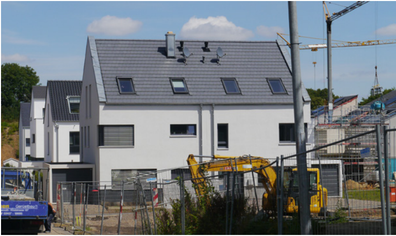
Abbildung 118: Neue Doppelhäuser auf kleinen Grundstücken, Aachen
