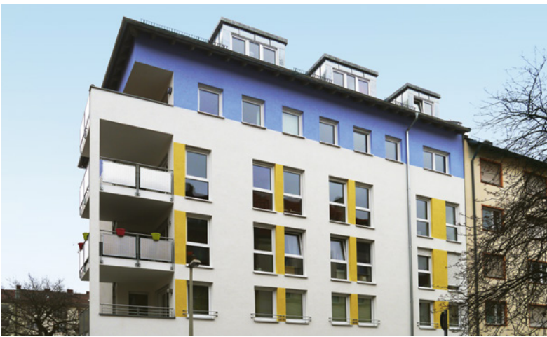
Abbildung 119: Neubau in günstigeren Lagen südlich der Altstadt, Nürnberg – St. Leonhard
