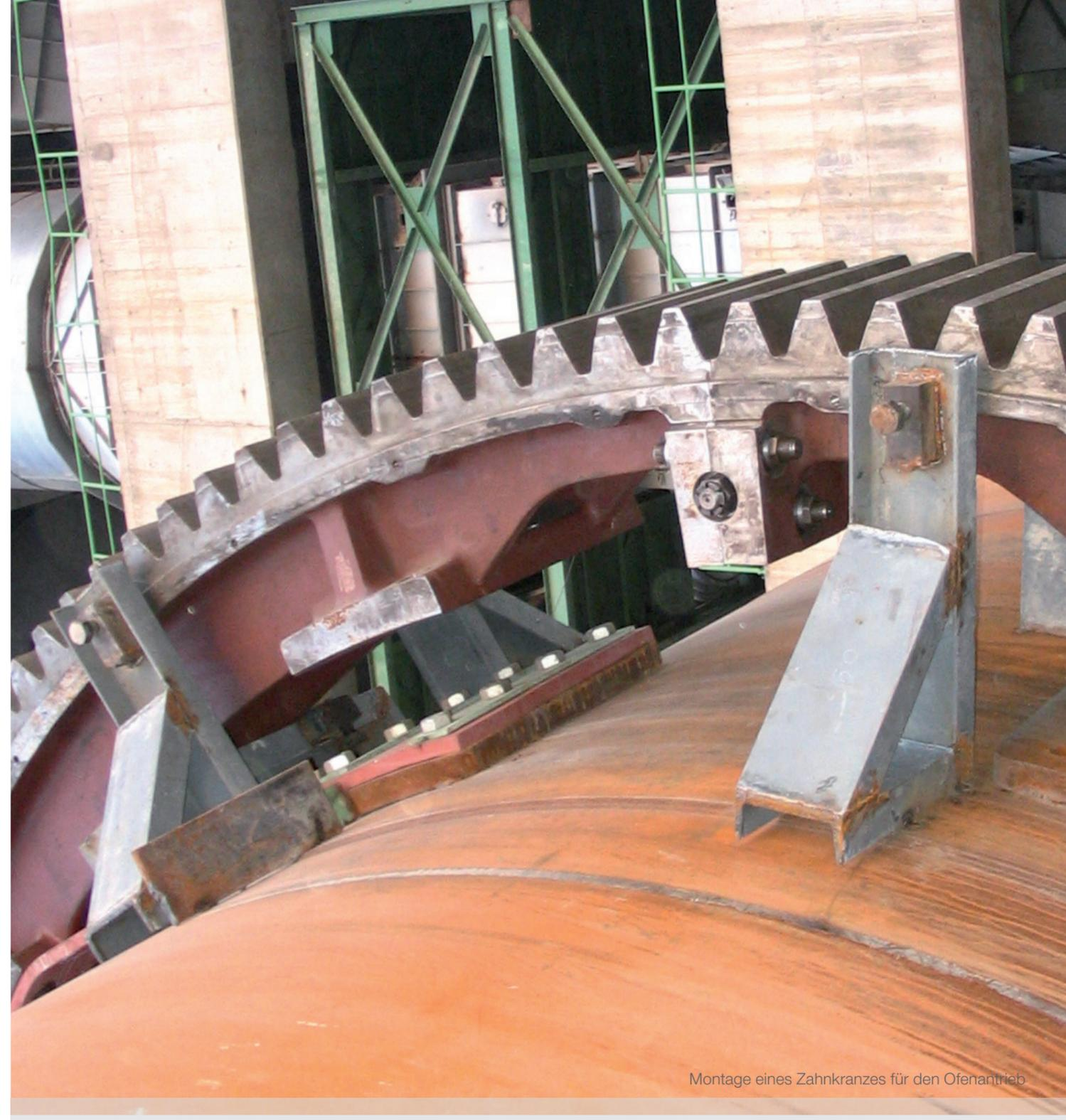
Montage eines Zahnkranzes für den Ofenantrieb
