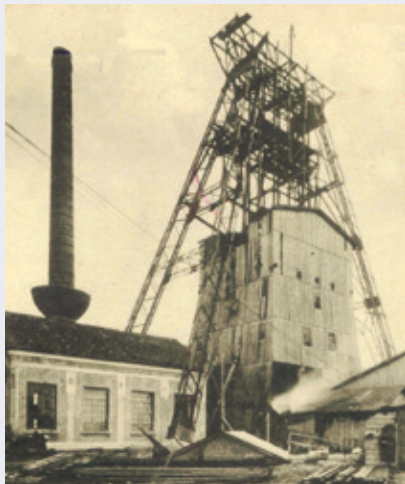
Förderturm im Aufbau, darunter noch der hölzerne Abteufturm, 1914.
