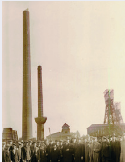
Seit 1938 ist der Abgasschornstein mit 120,04 m das höchste Gebäude der Zeche. Hier bei der Feier zu seiner Fertigstellung. (links) Zwei Kühltürme mit 22 m Höhe für das Maschinenhaus.
