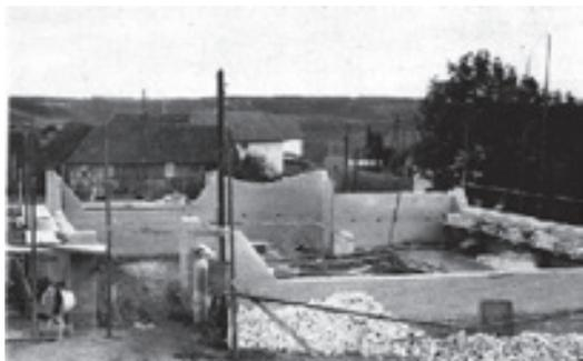
Der Bau hat begonnen. Alle Außen- und Innenwände wurden mit Kalksandsteinen als Sichtmauerwerk errichtet.
