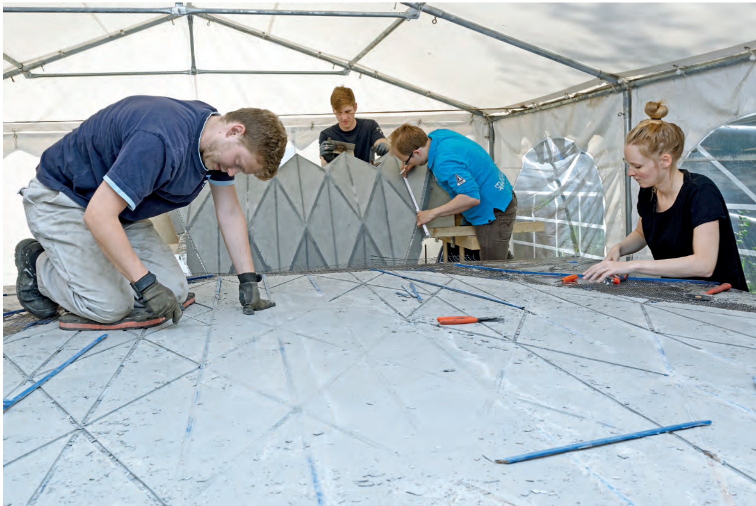
Bild 6: Lehramt mit beruflicher Fachrichtung Hochbautechnik ist in NRW nur an der RWTH studierbar. Das Foto zeigt das Herauslösen von Beton-Faltwerkschalen aus einer Gussform im Institut für Massivbau. Foto: Peter Winandy
