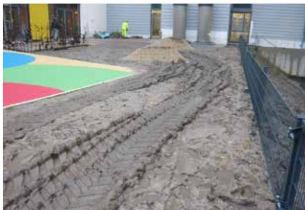
Abbildung 4.2: Verdichteter Boden (THIEME-HACK).
