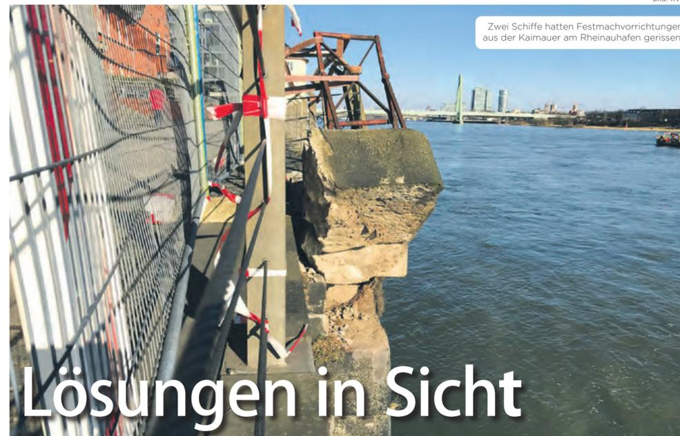
Zwei Schiffe hatten Festmachvorrichtungen aus der Kaimauer am Rheinauhafen gerissen.
