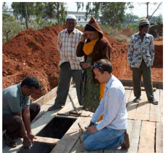
Im indischen Bangalore kontrolliert ein Freiwilliger den Bau einer Abwasseraufbereitungsanlage.
