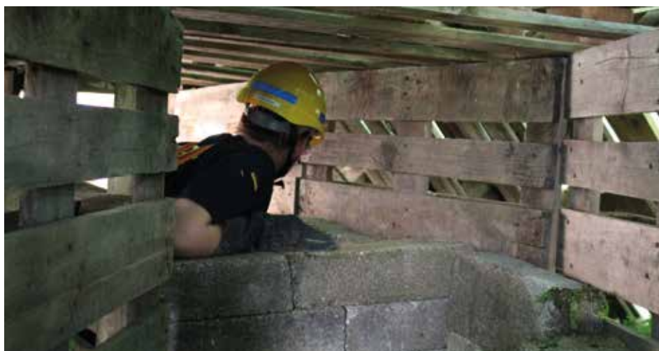
Hindernisse im Kriechgang erschweren die Arbeit zusätzlich.
