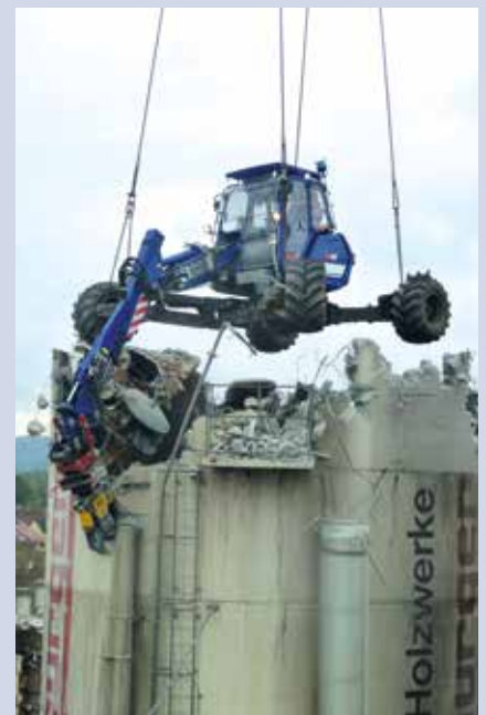
Eine Einsatzmöglichkeit des Schreitbaggers, die ohne Fernsteuerung nicht möglich wäre.
