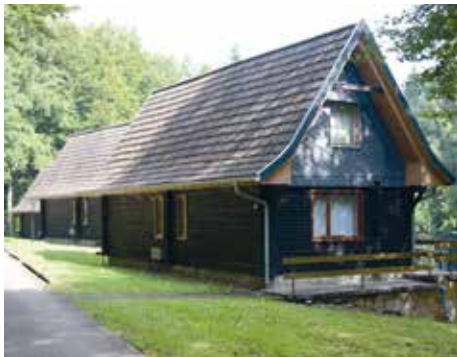
Die drei Bungalows werden in den kommenden Jahren der Reihe nach saniert.
