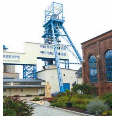
Das Fördergerüst markiert den Eingang zum Brüggman-Schacht des Kalibergwerks „Glückauf“ in Sondershausen.
