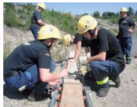
Behelfsbrückenbau: Zur Not geht mehr als man denkt.
