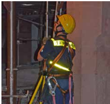
Hier war die Beleuchtung augenscheinlich zu gering.
