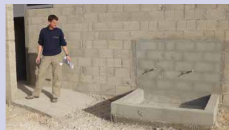
Jens-Olaf Knapp vor einem Sanitärzentrum.
