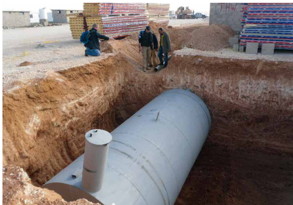
Mit den lokalen Baufirmen werden die Details direkt vor Ort besprochen.
