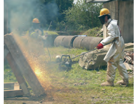
Schneidet Beton wie Butter: die Sauerstoffflanze.
