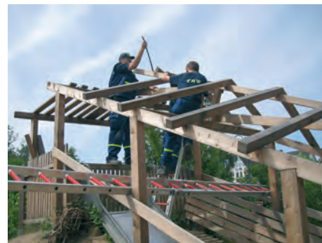
Die Arbeiten erfordern viel Geschick.
