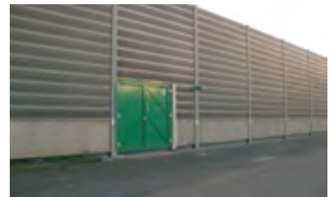
Flucht-Türe in der Lärmschutzwand der Autobahn A 8 bei Leonberg.
