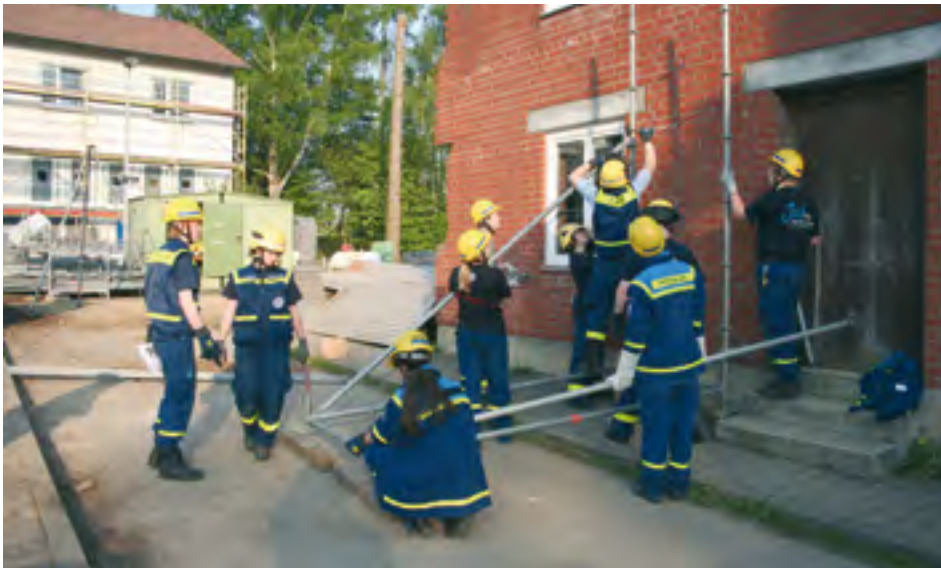
Ruck-Zuck lässt sich mit dem Einsatz-Gerüstsystem eine Wand abstützen.
