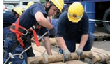
Stegebau mittels präzise verschnürter Hölzer.
