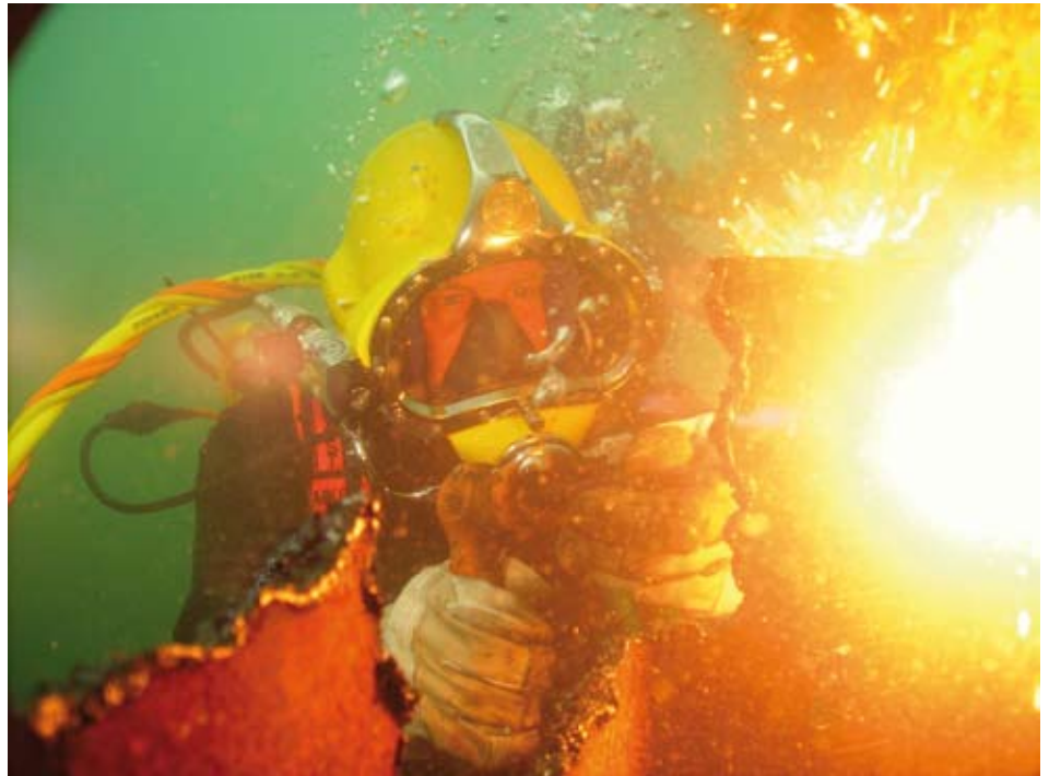
Auch das geht unter Wasser: Brennschneiden mit einer Sauerstoffflanze.
