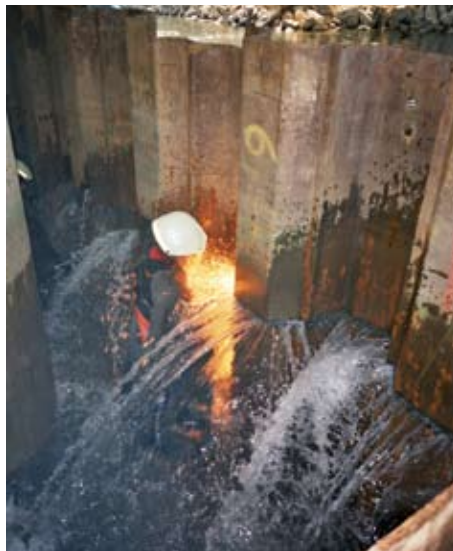
Aus dem vielfältigen Alltag: Beseitigen von Spundwänden an einem Brückenpfeiler.
