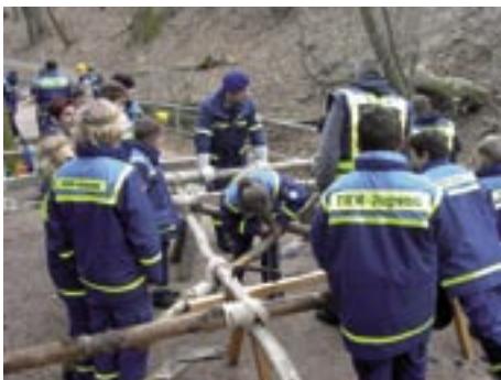
Gemeinsam Hand angelegt: Stück für Stück wächst die Brücke.
