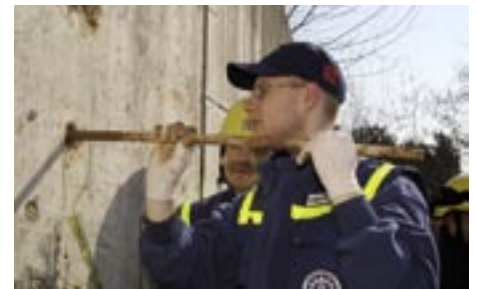
Ein Bohrloch wird mit Sprengstoff „geladen“.
