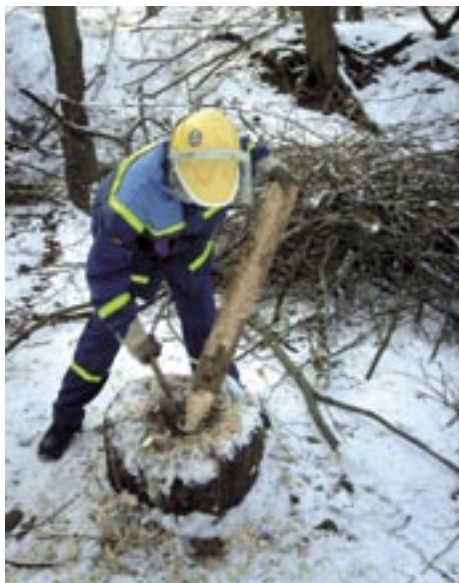
Statt Frieren doch lieber anstrengen: Das wird eine Stütze für die schiefe Ebene.
