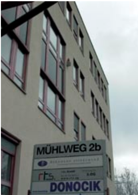
In diesem Bürogebäude werden die Versicherungsfälle für die THW-Jugend abgewickelt.
