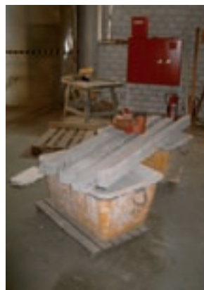
Bauarbeiten an allen Ecken. Schließlich soll gutes noch besser werden.
