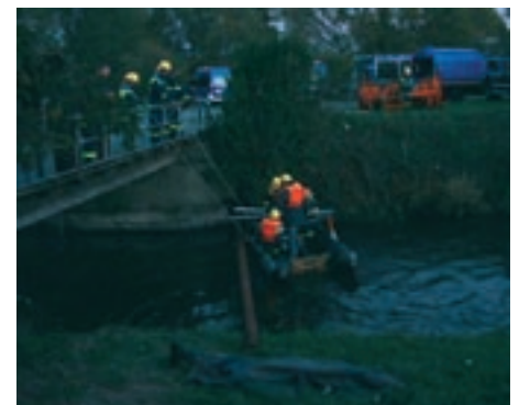
Sicherung der Versorgungsleitung.
