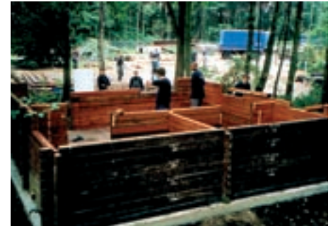
Das Blockhaus ist fast wieder vollständig auf dem Unterkunftsgelände errichtet.
