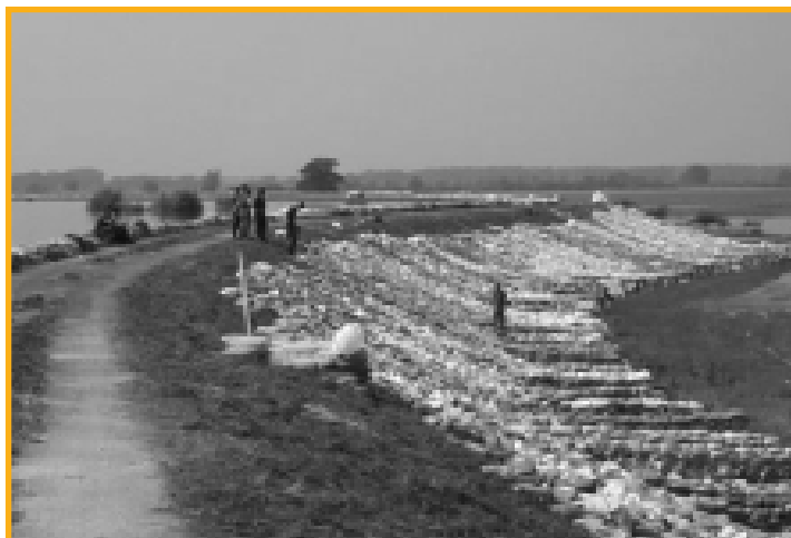
Blick auf einen gesicherten Deichabschnitt der Elbe in Höhe von Wittenberge
