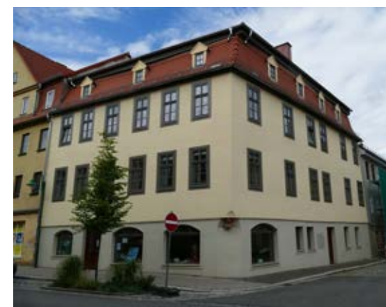
Neustädter Straße 7 vor (oberes Bild, Quelle: KEWOG Städtebau GmbH) und nach der Sanierung (unteres Bild, Quelle: IRS)
