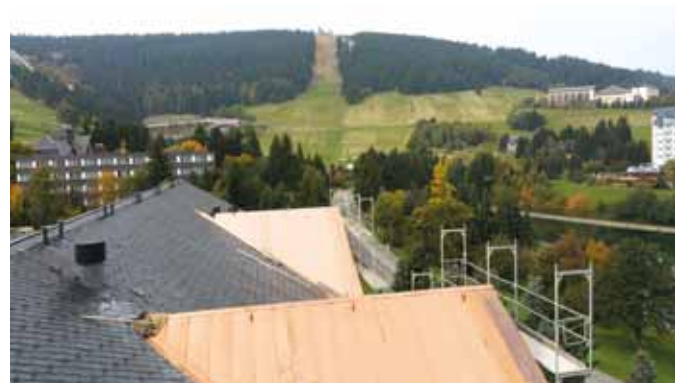
Bei den Arbeiten am Dach und der Installation des Schneefang-Systems hatten die Bauarbeiter einen tollen Ausblick. Bilder: BwSW
