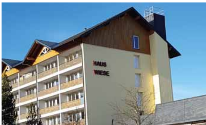
Bis zum Abschluss der Bauarbeiten wird der Schriftzug „Haus Wiesenthal“ vervollständigt.
