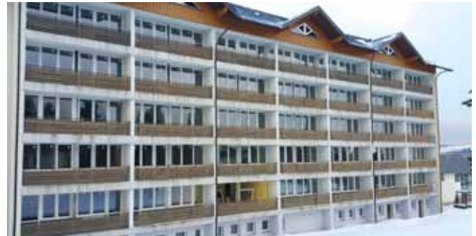
Die neuen Fenster sind Teil der energetischen Sanierung.
