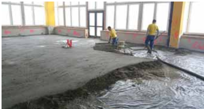
Nach dem Ausräumen und der Entkernung wurde neuer Estrich u. a. im Speisesaal verlegt und neue Wände hochgezogen.
