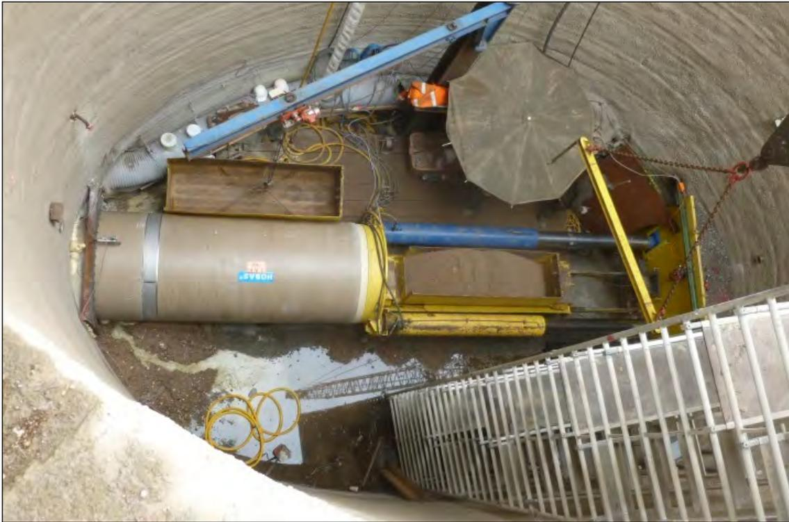
Abbildung: Startbaugrube Rohrvortrieb
