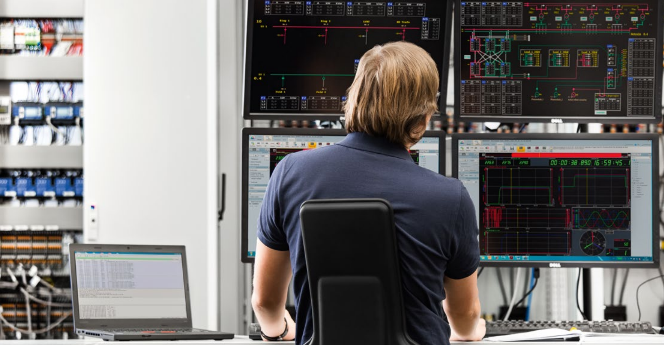
Abbildung 1: Leitwartenstand im Zentrum für Netzintegration
