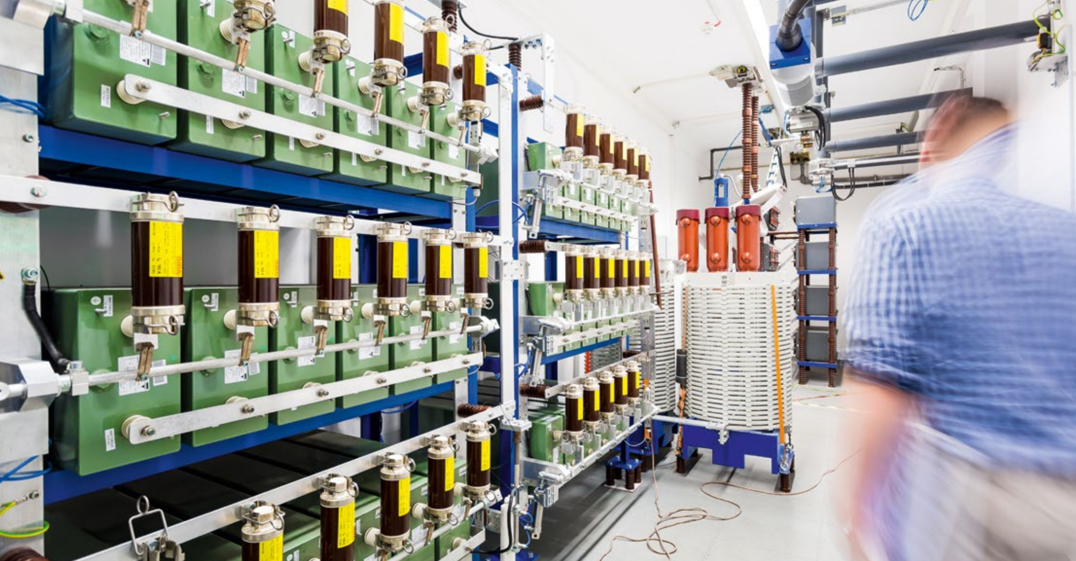
Weil-Dobke-Prüfkreis zur synthetischen Leistungsschalterprüfung
