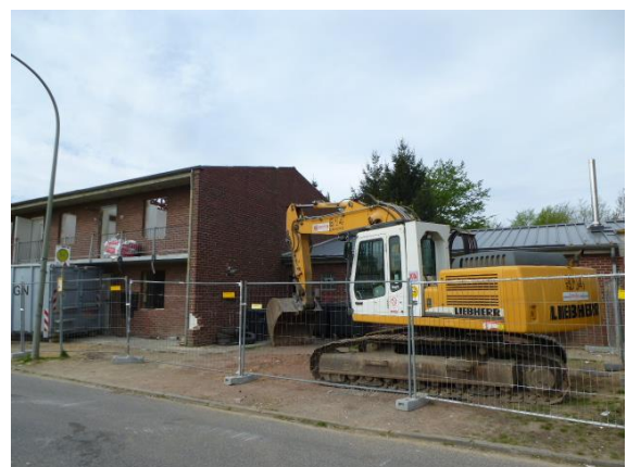
Abbruch Obdachlosenheim Neuhaus 48
