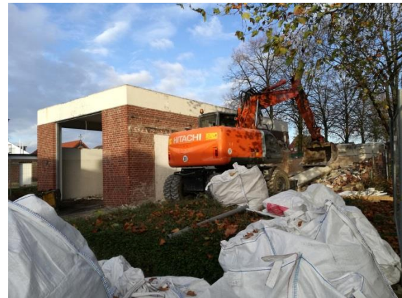
Abbruch Feuerwehrgerätehaus Hetzerath
