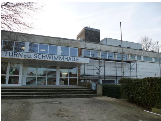
Sanierung Turn- / Schwimmhalle Gerderath
