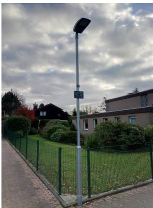
Sanierung Beleuchtung Schreder TECEO
