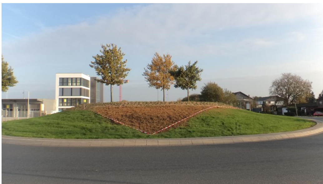
Vorbereitung Neugestaltung Kreisverkehr an der B57/GIPCO/Luxemburger Str. Fertigstellung geplant bis Ende November 2017.
