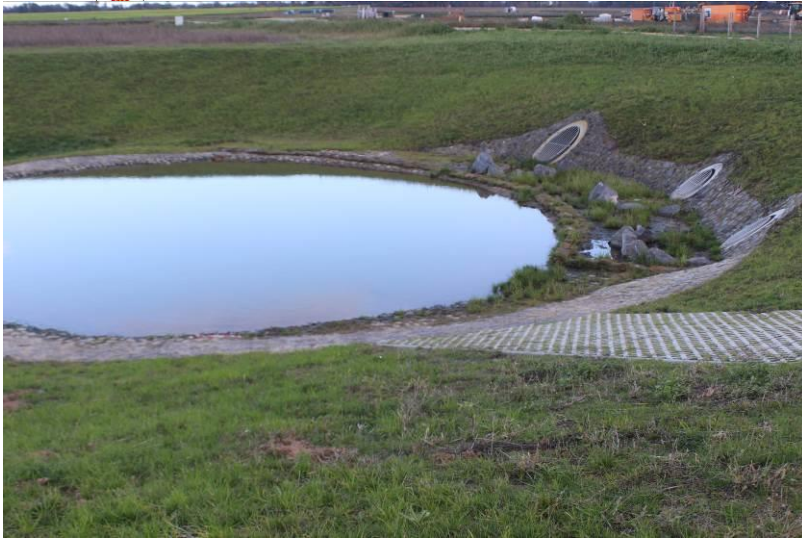
Foto 1: Zentrales Versickerungsbecken
