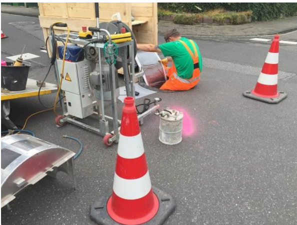
Inlinersanierung „Am Schneller“
