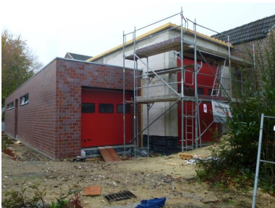
Neubau Feuerwehrgerätehaus Katzern
