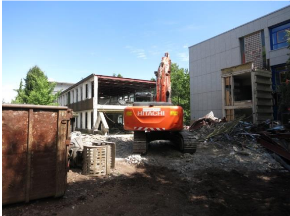
Abbruch „Roland-Bau 1“ Cusanus-Gymnasium
