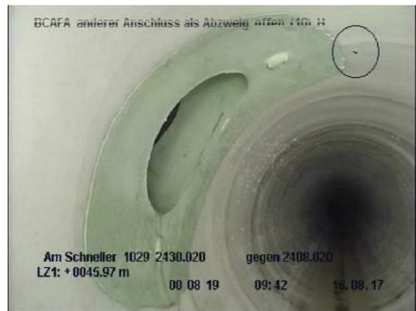
Sanierte Haltung „Am Schneller“
