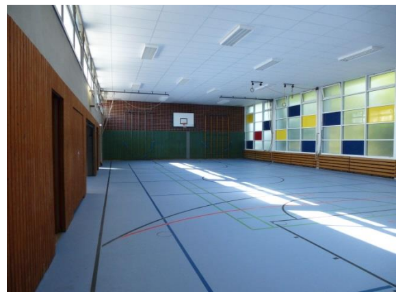
Ern. Hallenboden / Akustikdecke TH Gerderath
