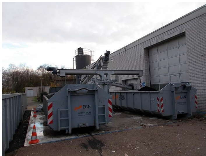
Foto 3 Abtransport entwässerter Schlamm
