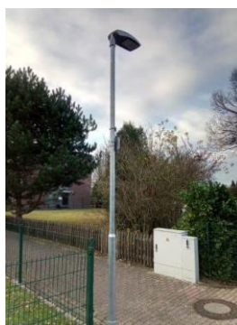
Sanierung Beleuchtung Schreder TECEO
