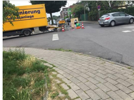
Inlinersanierung „Am Schneller“
