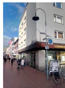
Sanierung Leuchte Innen- stadt AEC Goblet
