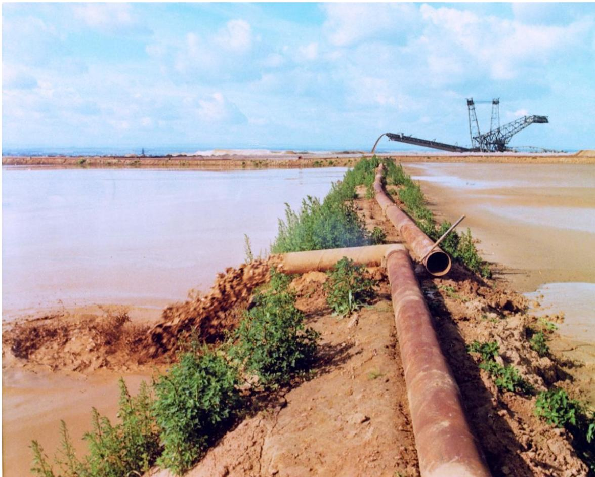
Abbildung 9: Früher angewandtes Spülverfahren zum Lössauftrag.
