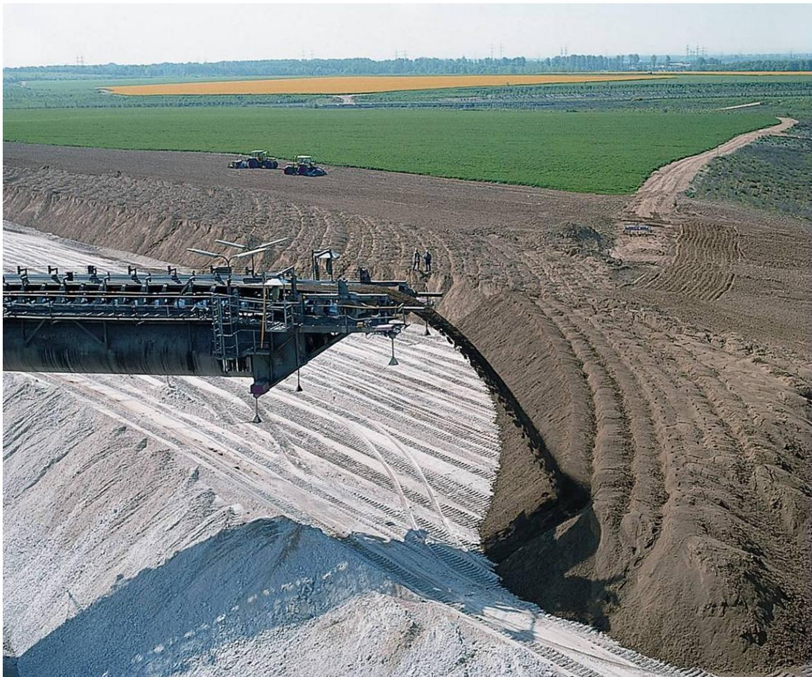
Abbildung 10: Trockener Lössauftrag mit dem Absetzer.
