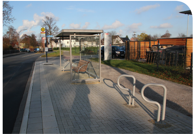
Abb. 12: Muster einer modernen und barrierefrei ausgebauten Haltestelle
