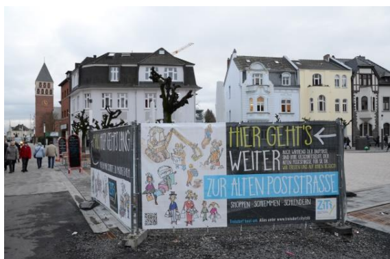
Baustellenbanner im ZiTi-Design (Quelle: Absolut Avaris GbR)
