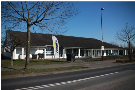
Kärcher, Lülisdorfer Straße 50 (Quelle: TROWISTA GmbH)
