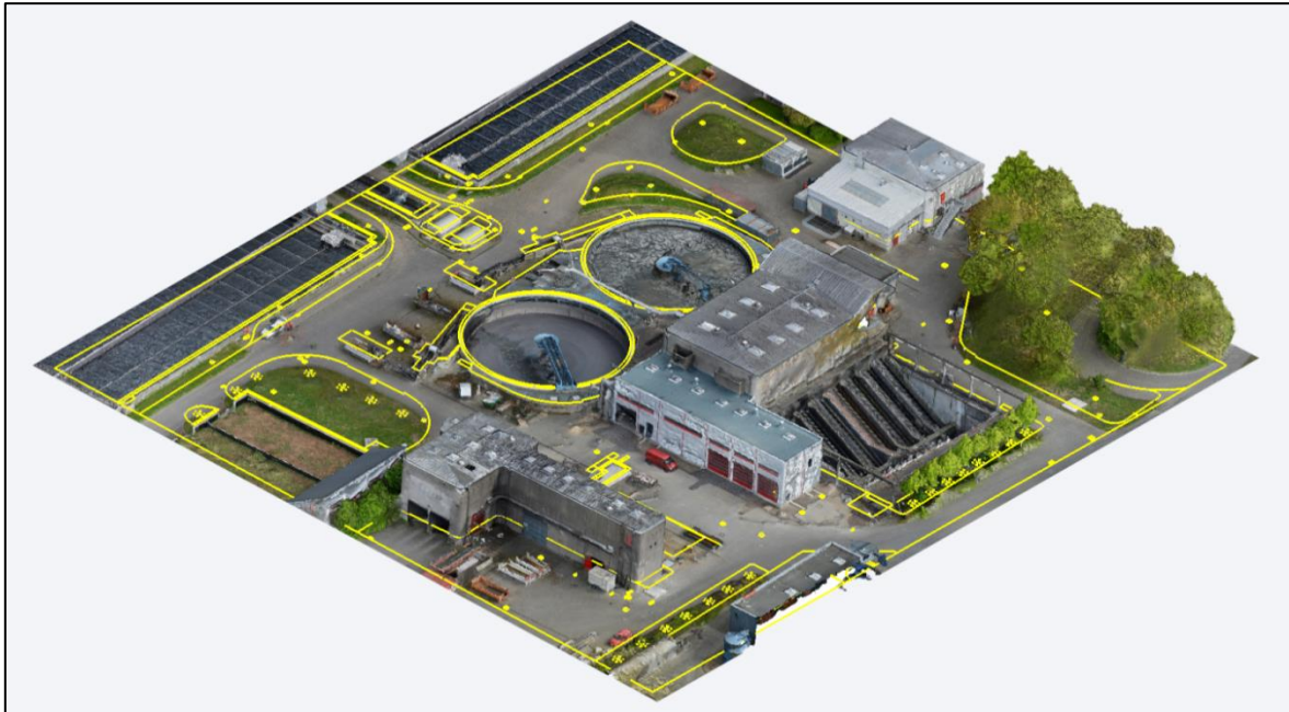
Abb. 1: Anlagen des Klärwerkes Düsseldorf Süd – Overlay aus photorealistischer Punktwolke der UAV-Befliegung in Kombination mit terrestrisch aufgenommenen Vermessungen (gelb)
