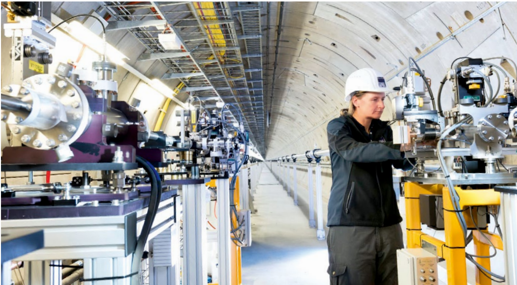
Einblick in den 500 Meter langen Photonen-Tunnel XTD9 der Röntgenquelle XFEL während der Bauphase. Durch ihn werden die erzeugten Röntgenblitze zu den Experimenten geleitet.
