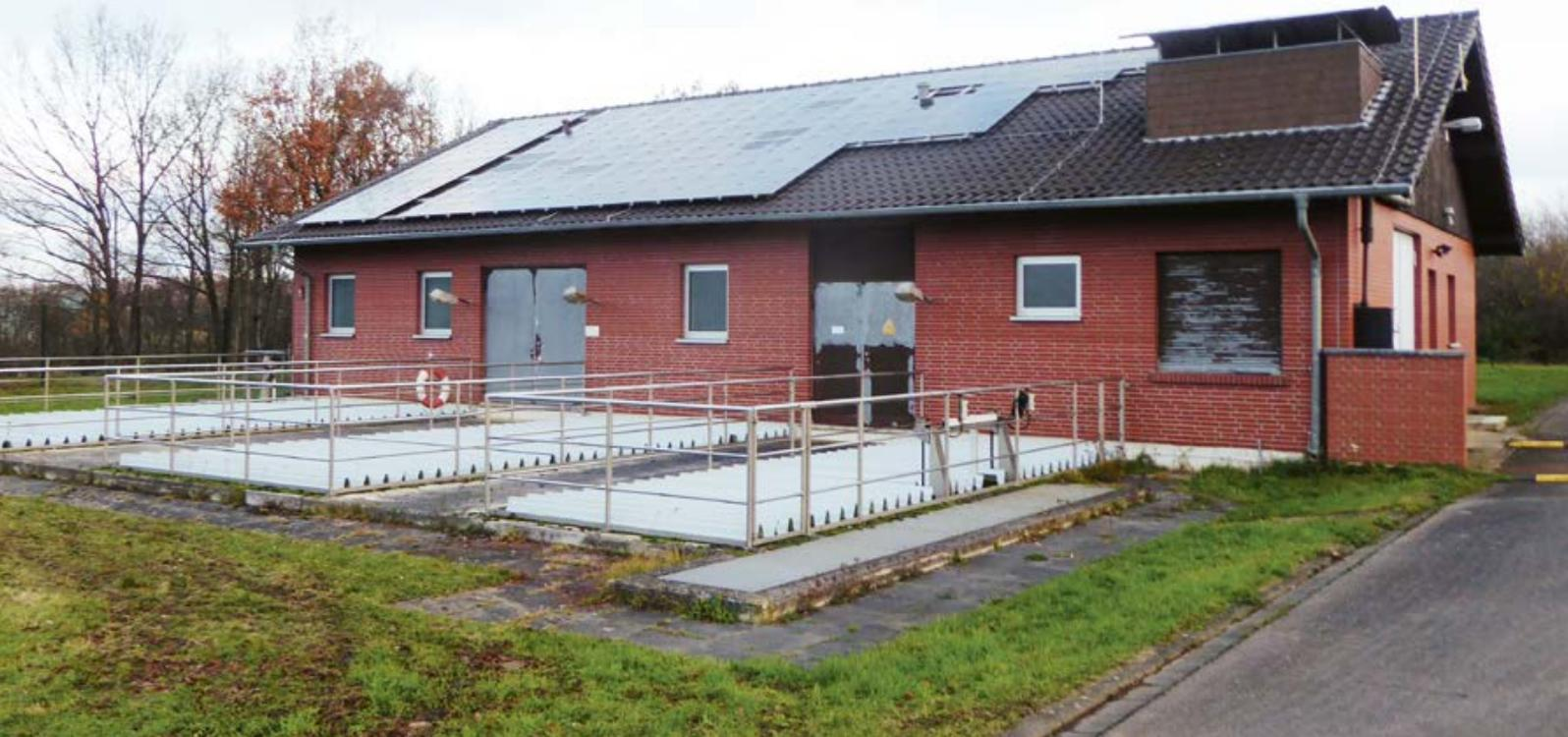
Filtrationsgebäude und abgedeckte Nachnitrierung
