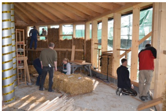
Beim Errichten des Strohballenhauses wurde selbst Hand angelegt. Foto: Henning Austmann
