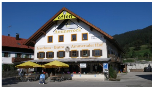
Der sanierte Ammertaler Hof. Foto: Viola Erhard
