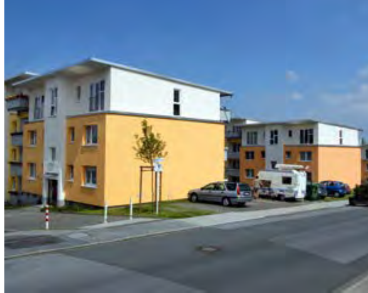
Aufstockung in Witten: nachher Architekten: Trabandt Architektur, Fotos: André Grabowski
