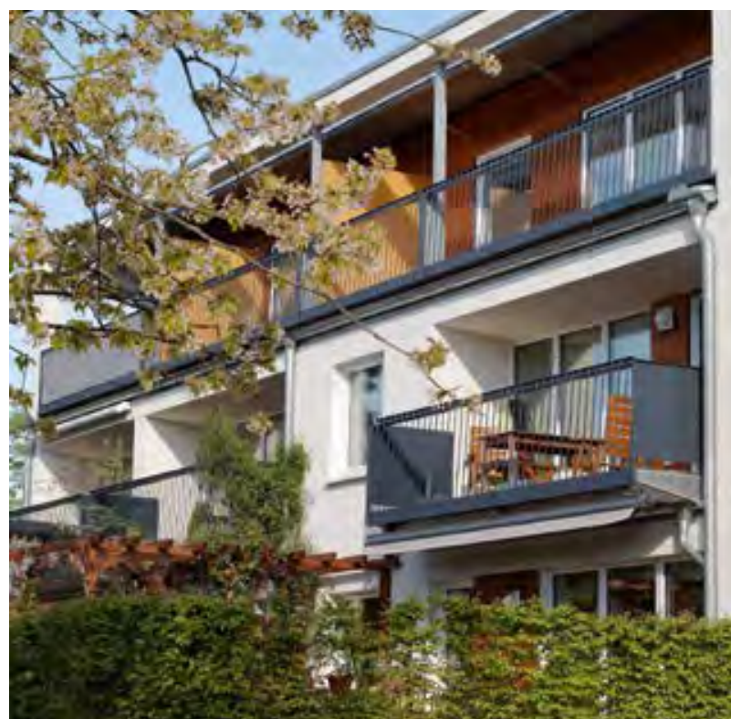
Architekt: H. W. Hinsenhofen, pi architektur Fotos: Reinhard Schwederski
