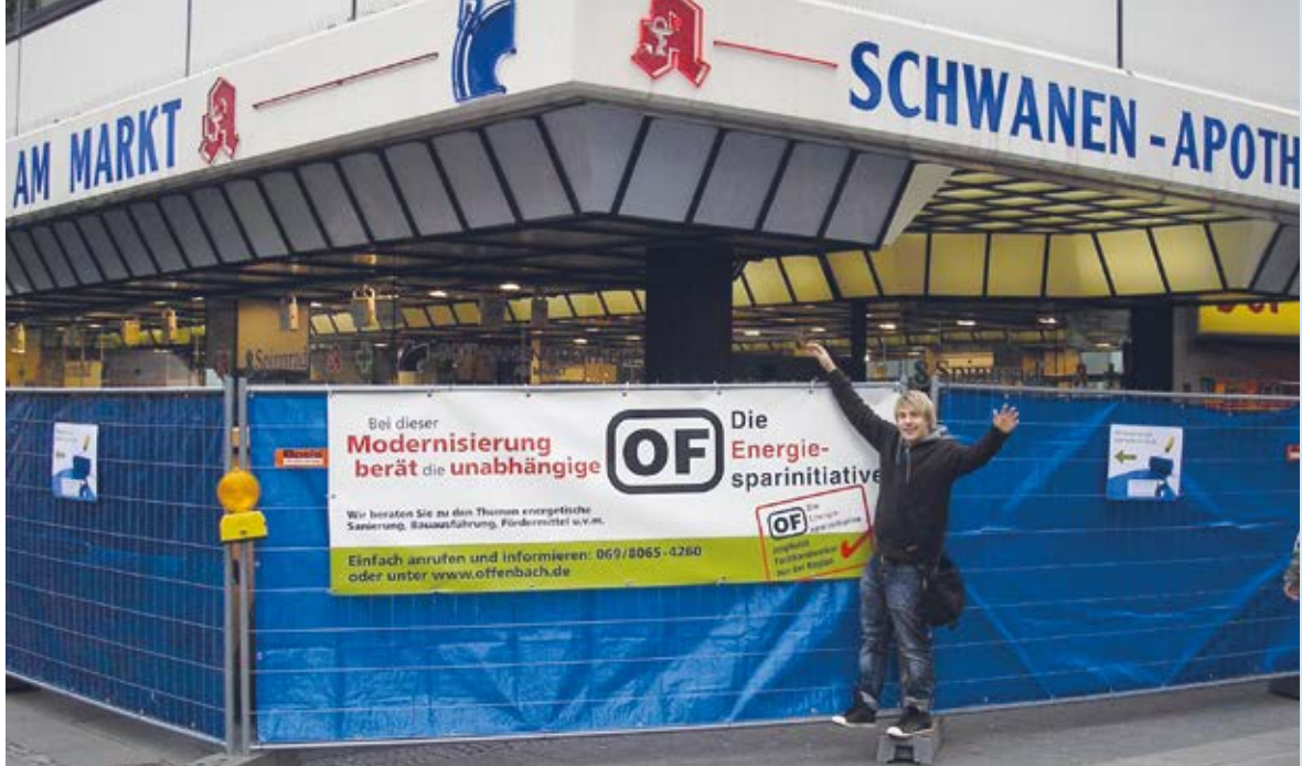
Öffentlichkeitswirksame energetische Sanierung
