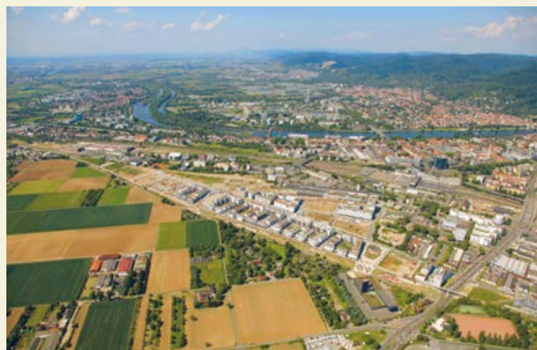
Passivhaus-Stadtteil Bahnstadt Heidelberg in der Entstehung
