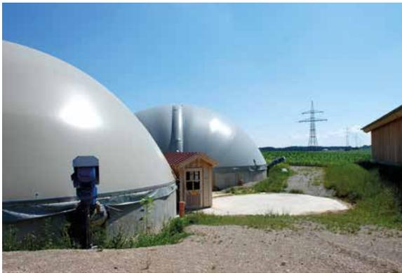
*Mit Gülle betriebene Biogasanlage*
