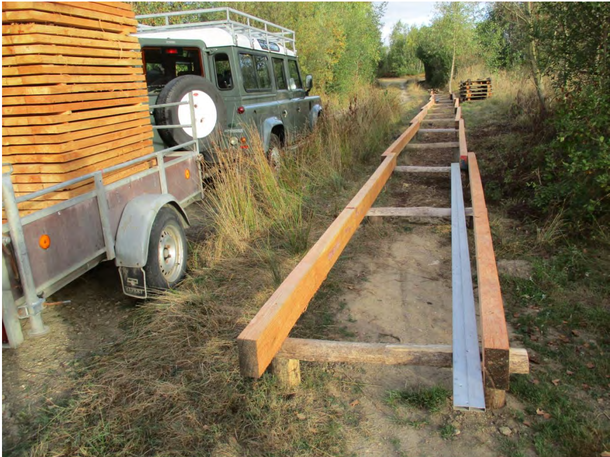
Abb. 61: Bau einer barrierefreien Steganlage in der Drover Heide
