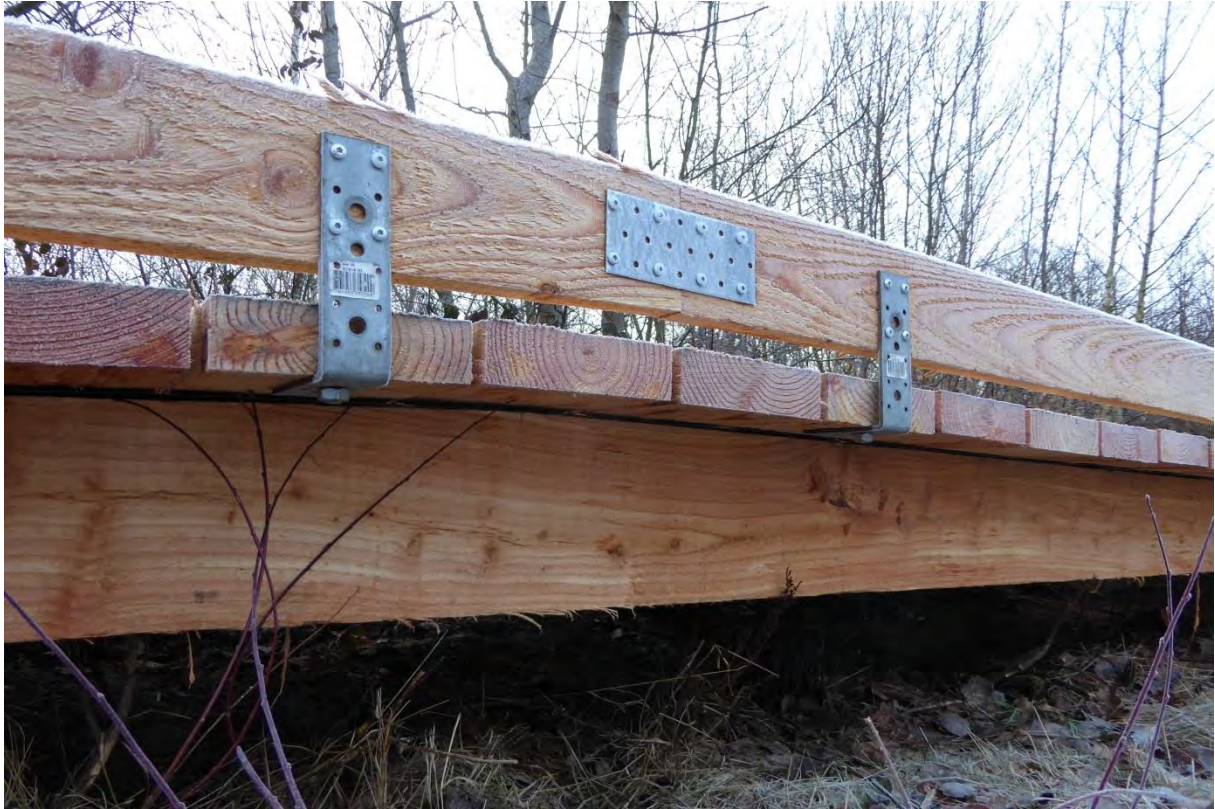
Abb. 62: Der Radabweiser der Steganlage
