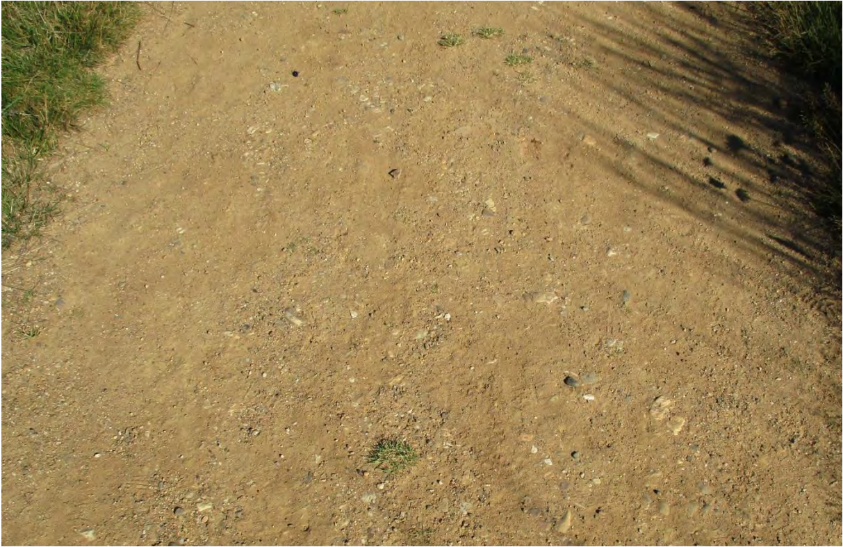
Abb. 59: Für die Deckschicht wurde Bergkies verwendet.
