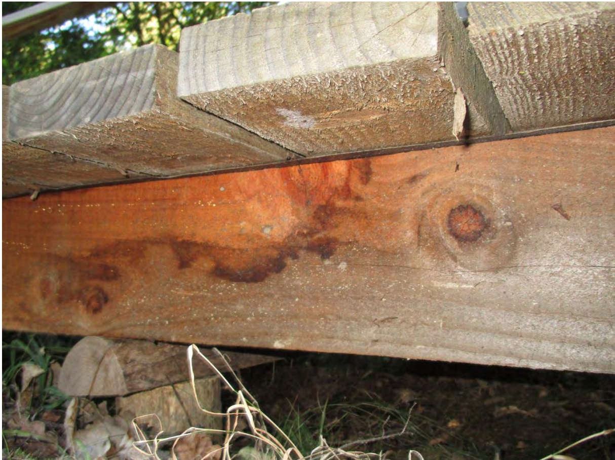
Abb. 56: Detailaufnahme der Stegkonstruktion
