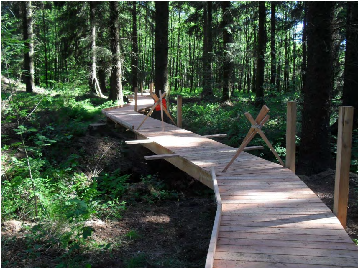
Abb. 55: Weiterer Bauabschnitt der Steganlage
