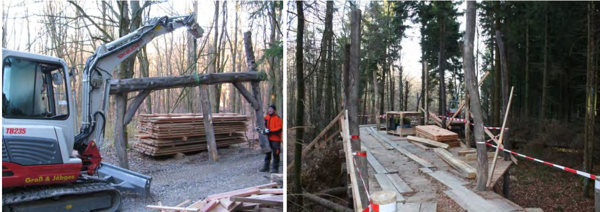
Abb. 44: Zum Bau des Holzstegs mit seinen Aufweitungen wurde eine Vor-Kopf-Bauweise gewählt.
