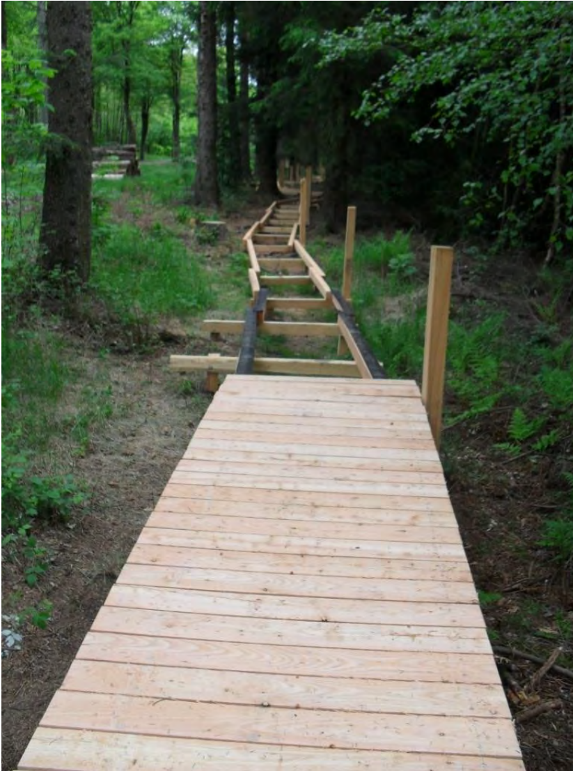
Abb. 54: Bauabschnitt der Steganlage
